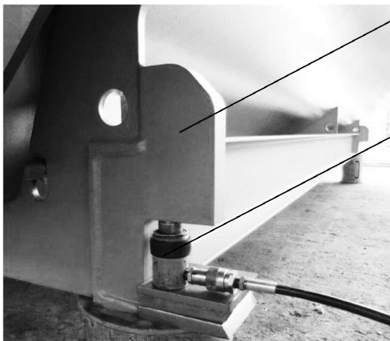
Рис. 1: Подъем котла с помощью подъемного приспособления (изображение для одной опоры котла)
